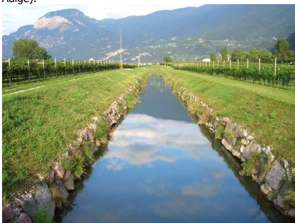
Foto 5: Tipologia 0 - Fossati di fondovalle artificiali- Fossa di Salorno (A.20) (Fonte: Provincia Autonoma di Bolzano-Alto Adige).
