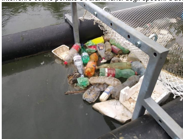
Figura 44. Barriere galleggianti per l'intercettazione dei rifiuti flottanti.
