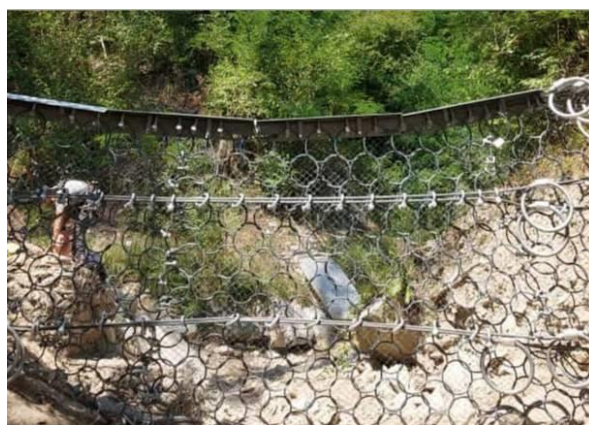
Figura 43. Briglia selettiva: griglia in acciaio per l'intercettazione dei rifiuti flottanti.
